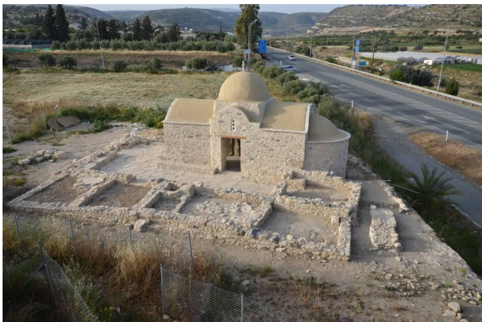
Εικ.1 Αγία Μαρίνα Καντού, μετά την ολοκλήρωση των έργων αναστήλωσης του ναού και συντήρησης των ερειπίων του αρχαίου μετοχίου (13 ος -15 ος )
